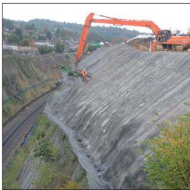
Installering av forankringer gjennom Deltax nett i skrånning
