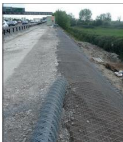
Anker montert i skrånings grop
